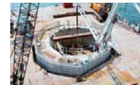
水中のコンクリート打設でセルクリート®Hを使用
